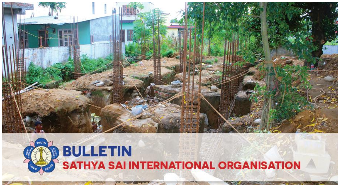
Izgradnja doma za djecu
